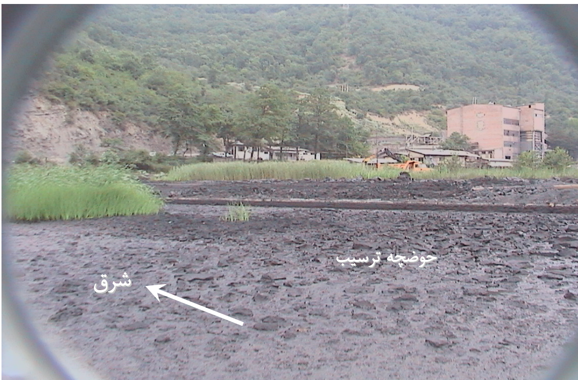
شکل ۶-۶- حوضچه ترسیب و موقعیت آن نسبت به ساختمان کارخانه.
