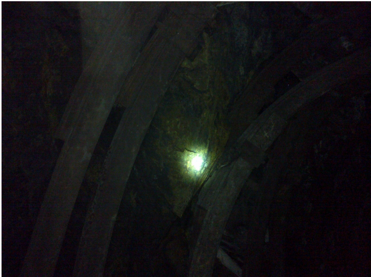
شکل ۱ - ریزش و فشار سقف تونلی و تخریب سیستم نگهداری
